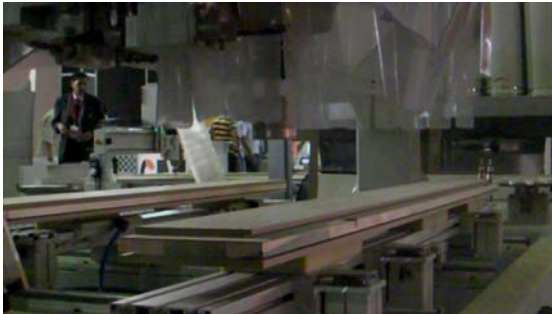
Kapı kasa montajı
